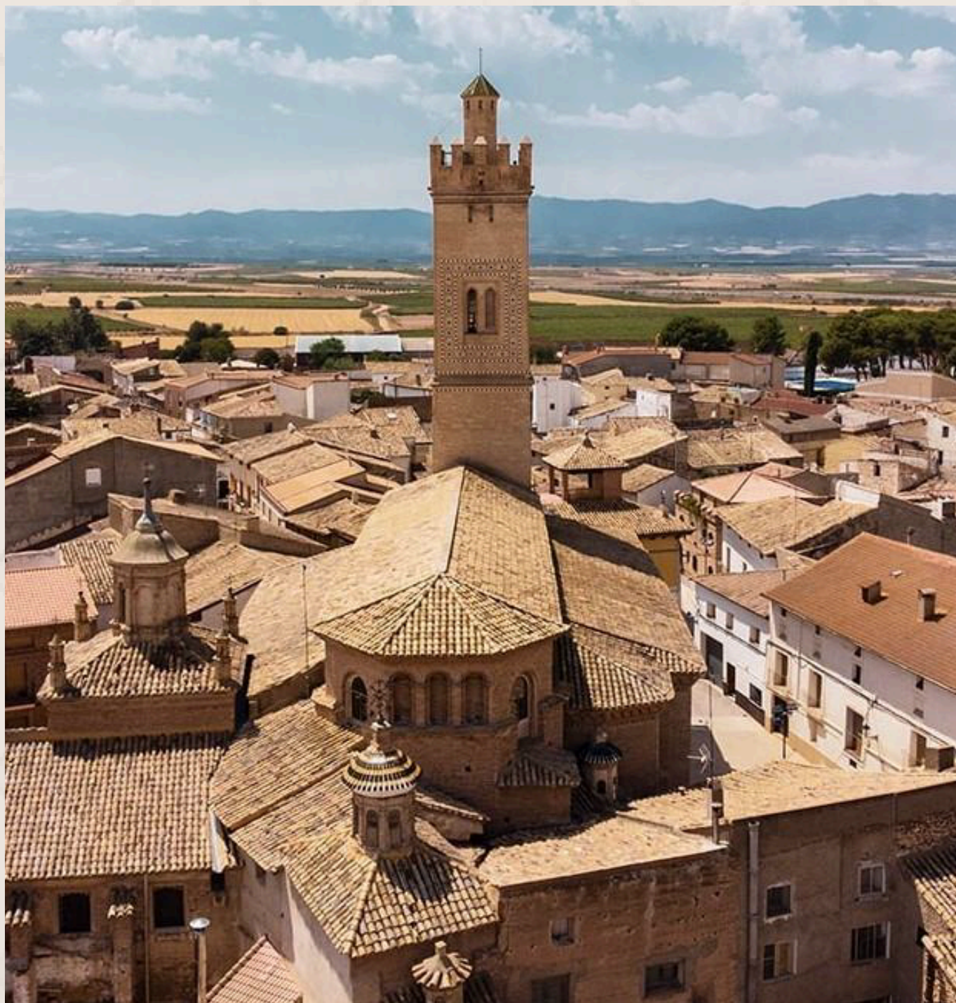
Torre de la iglesia de Longares (Zaragoza)
