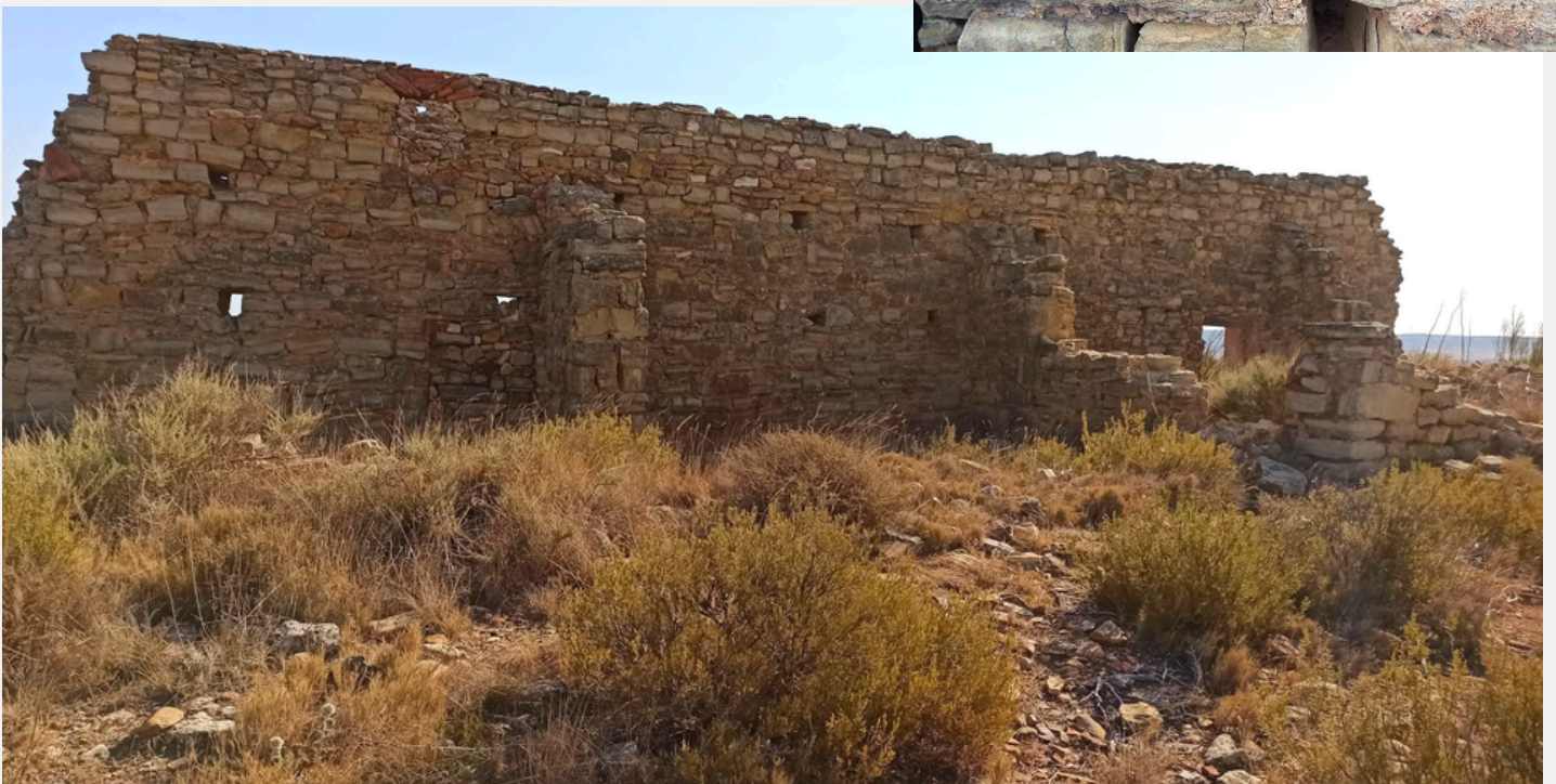
Vistas desde lo alto de San Pablo, única de las paredes de la ermita en pie y detalle de la numeración en unos de los bloques de piedra con los que se construyó.
