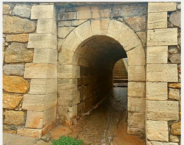
Sillar de piedra caracoleña y pequeño puente.
